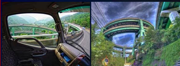
Preglednost na mostovima u krivina – minimalizacija elemenata nad kolnikom mosta (Most Kvazu Loop)
